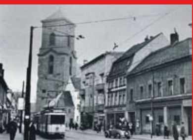
Nikolaikirche in Spandau (H. Fritz)
